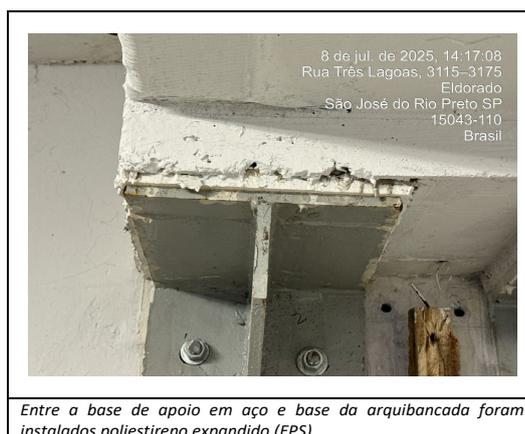
Entre a base de apoio em aço e base da arquibancada foram instalados poliestireno expandido (EPS)
