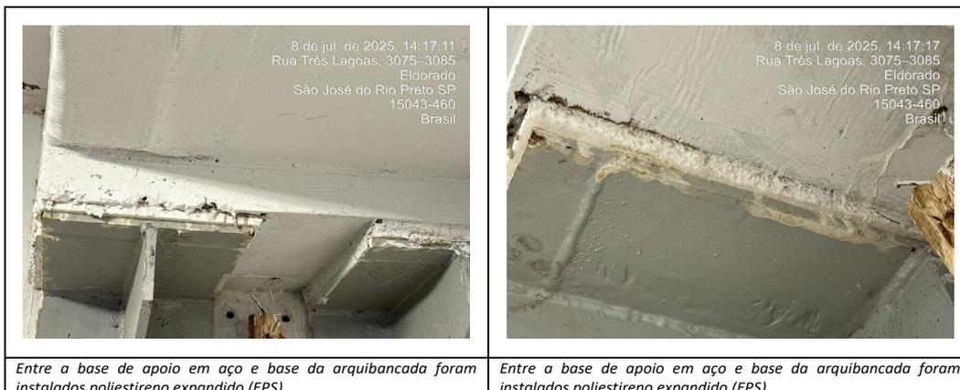
Entre a base de apoio em aço e base da arquibancada foram instalados poliestireno expandido (EPS)
